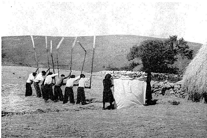
Fig. 39 — Malha na fase do vem . Chegados à borda da eirada no vai , inicia-se a malha às avessas com uma malhadela e um passo atrás. As mulheres com a manta vão acompanhando o recuo dos malhadores, amparando o grão que salta.
