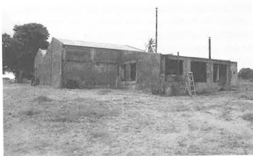
Fotografia 1 – Vista geral do pavilhão principal da fábrica
